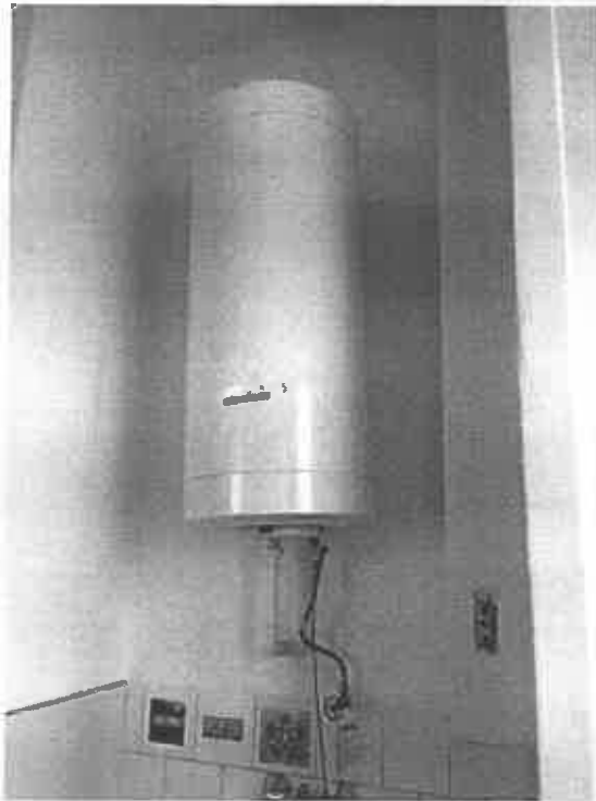
Unical kondenzációs kazán, időjáráskövető vezérléssel, és a HMV-t biztosító bojler
