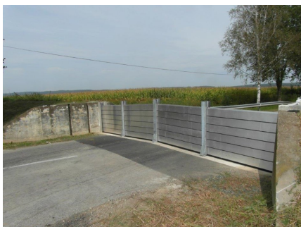
Mobilgát lezárás a rönöki út árvízi kapujában
