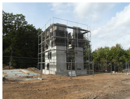
Kilátó épület 8,4 m magas vasbeton szerkezete
