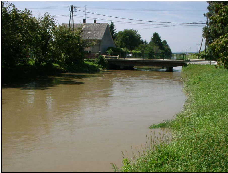
46. fotó: Vízierőmű üzemvíz csatornája
