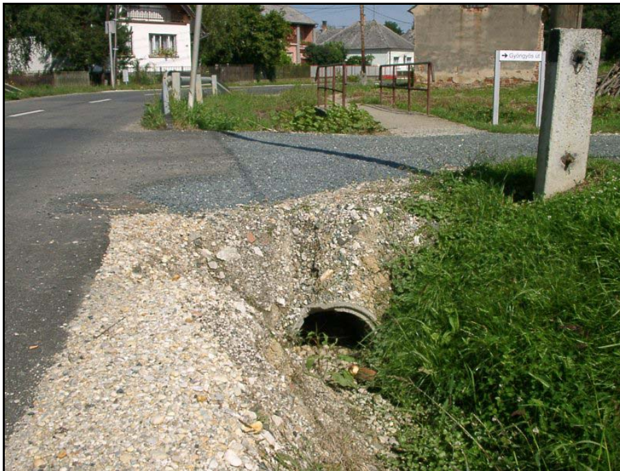
29. fotó: Eltömődött, felújításra szoruló csatornaszakasz
