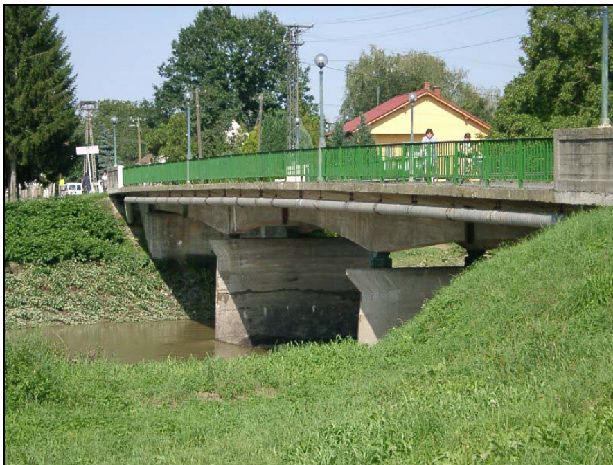
15. fotó: Rába felett ívelő közúti híd
