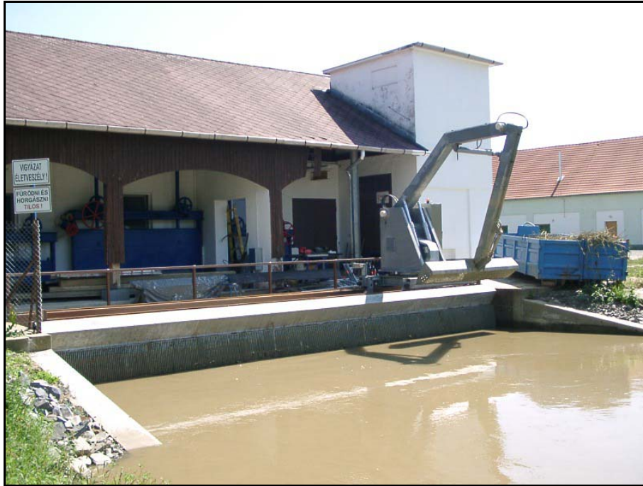
21. fotó: Vízerőmű II. (Csörötnek)
