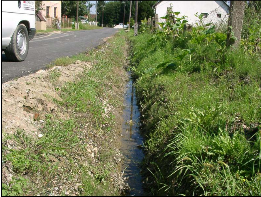
30. fotó: Pangó vízzel feltöltődött, felújításra szoruló csatorna
