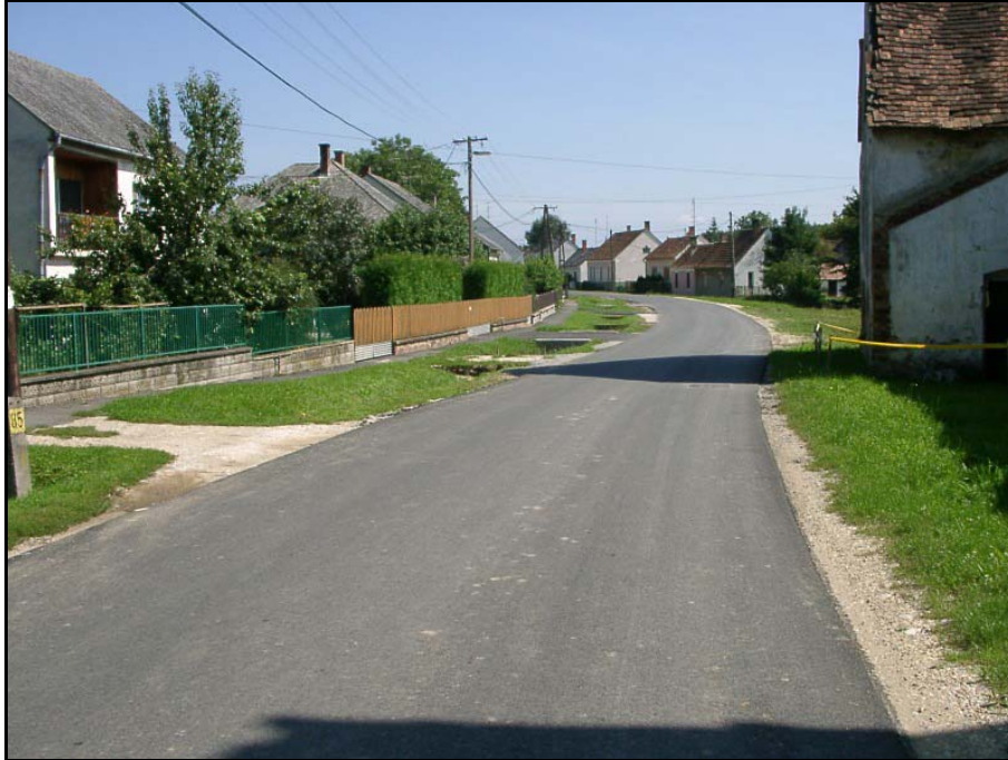
39. fotó: Csatorna-beruházás részeként felújított út
