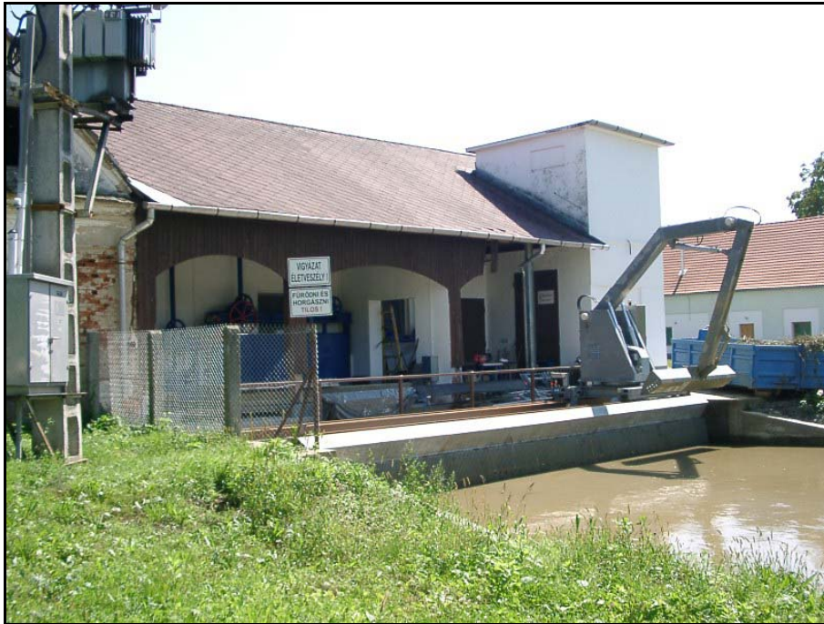
8. fotó: Vízierőmű (500 kW)
